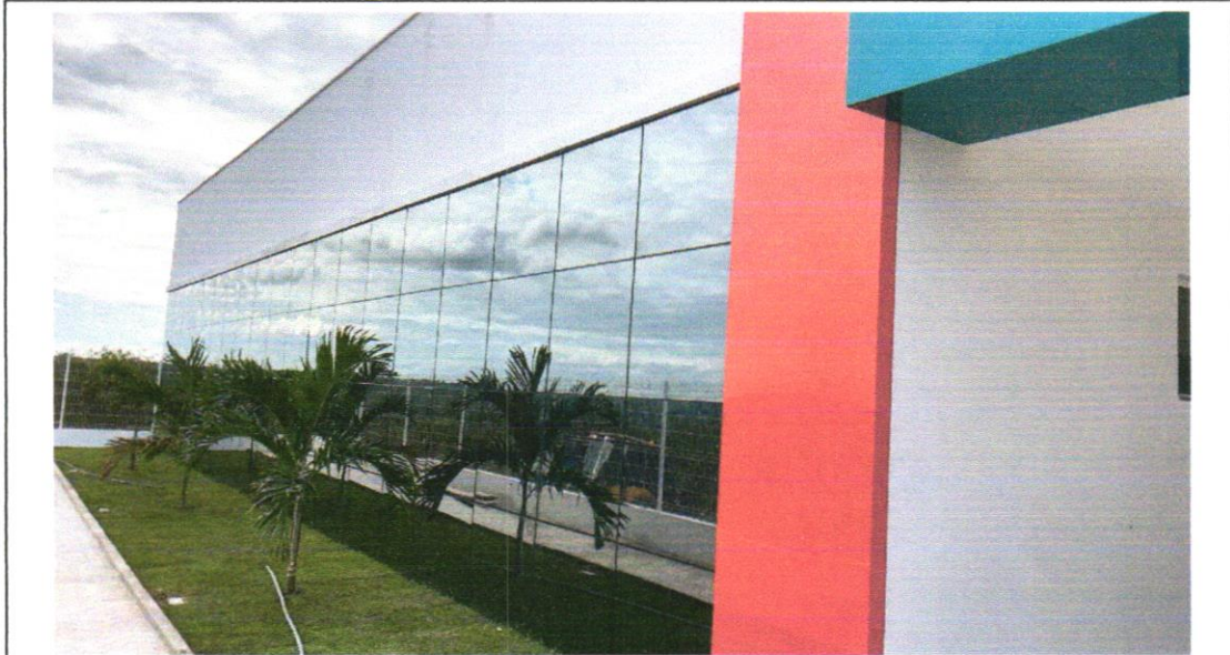
FOTO 266: VIDRO FACHADA E PAISAGISMO
